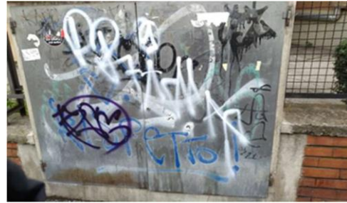
Pannello impianto su via Murri
